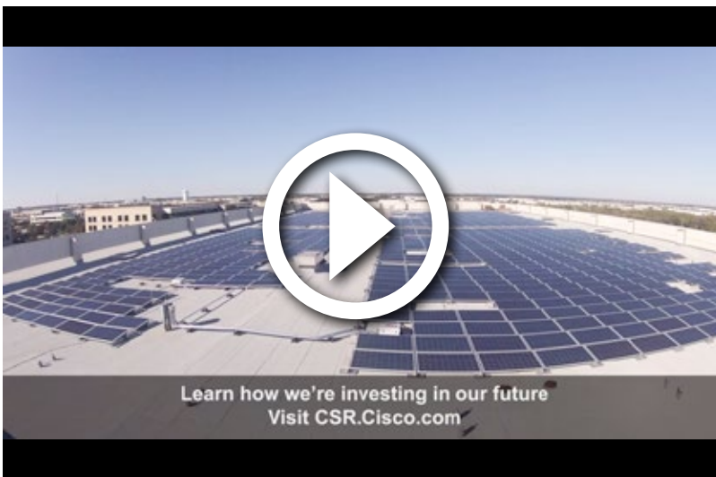
Video: come alimentare ad energia solare il Data Center Cisco di Allen, Texas
